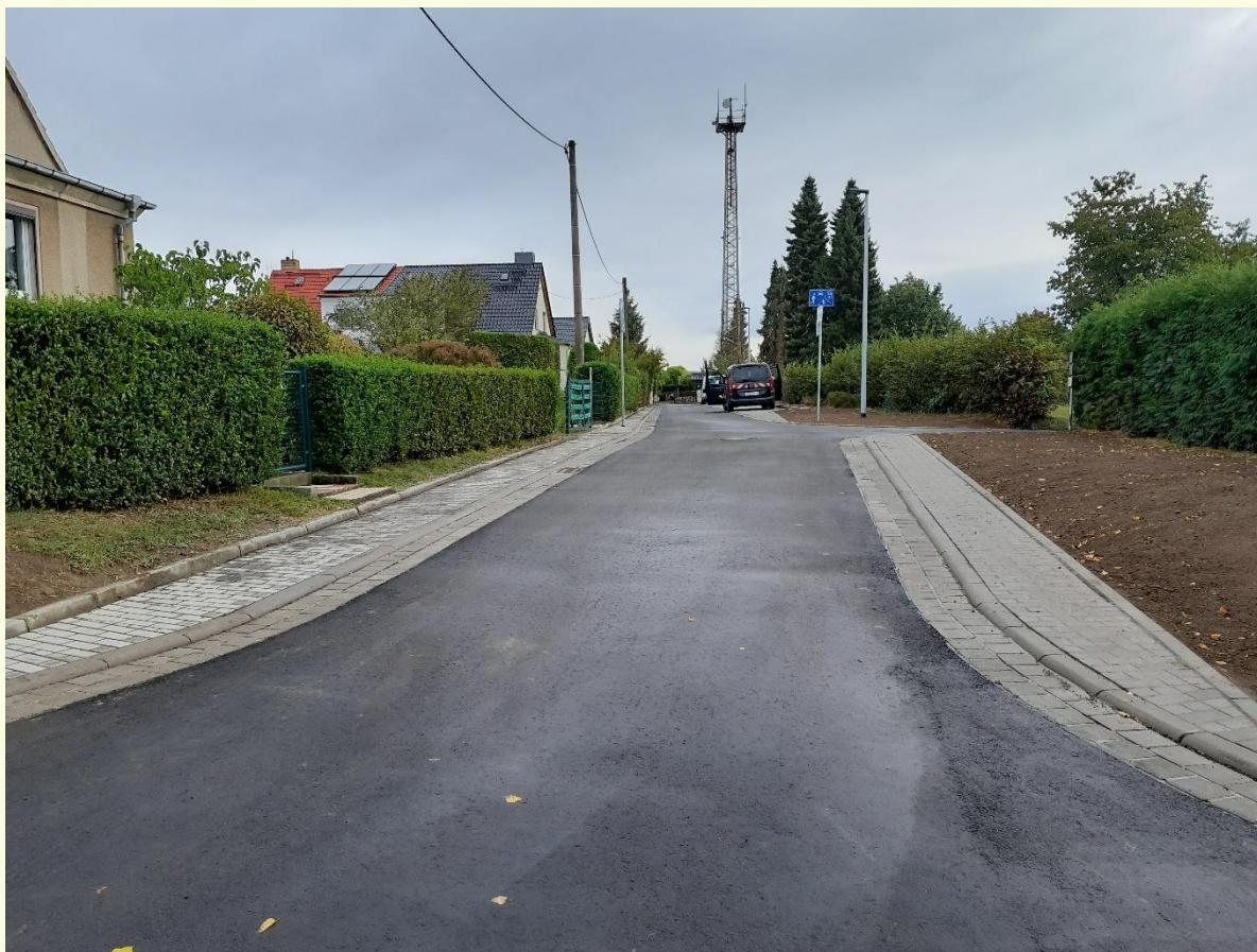
Fertigstellung des Straße des Aufbaus
