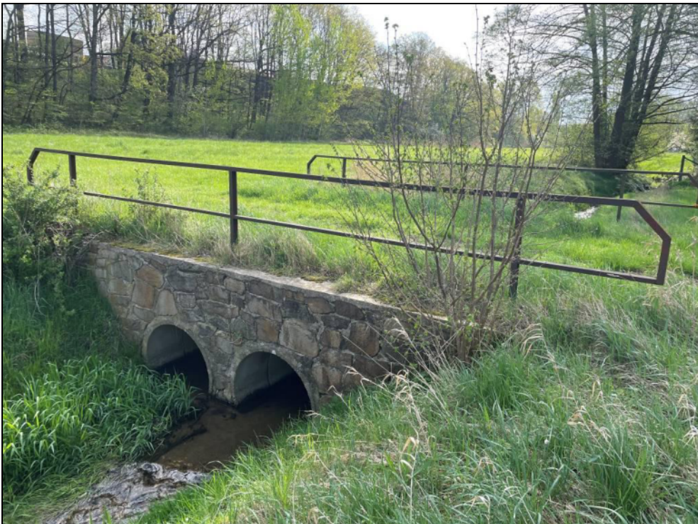
Bild 4: Verrohrter Bachabschnitt/Brücke über den Heinersdorfer Bach (12.04.2024).
